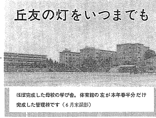
ほぼ完成した母校の学び舎。体育館の左が本年春半分だけ完成した管理棟です。(6月末撮影)
