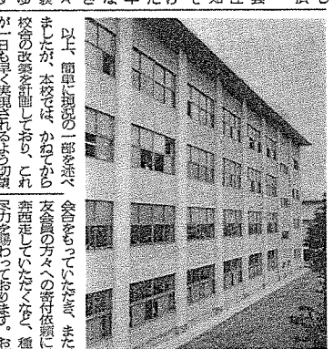
完成した新校舎
